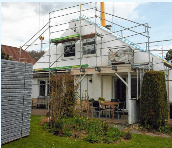
Während der Sanierungsarbeiten am Objekt.
