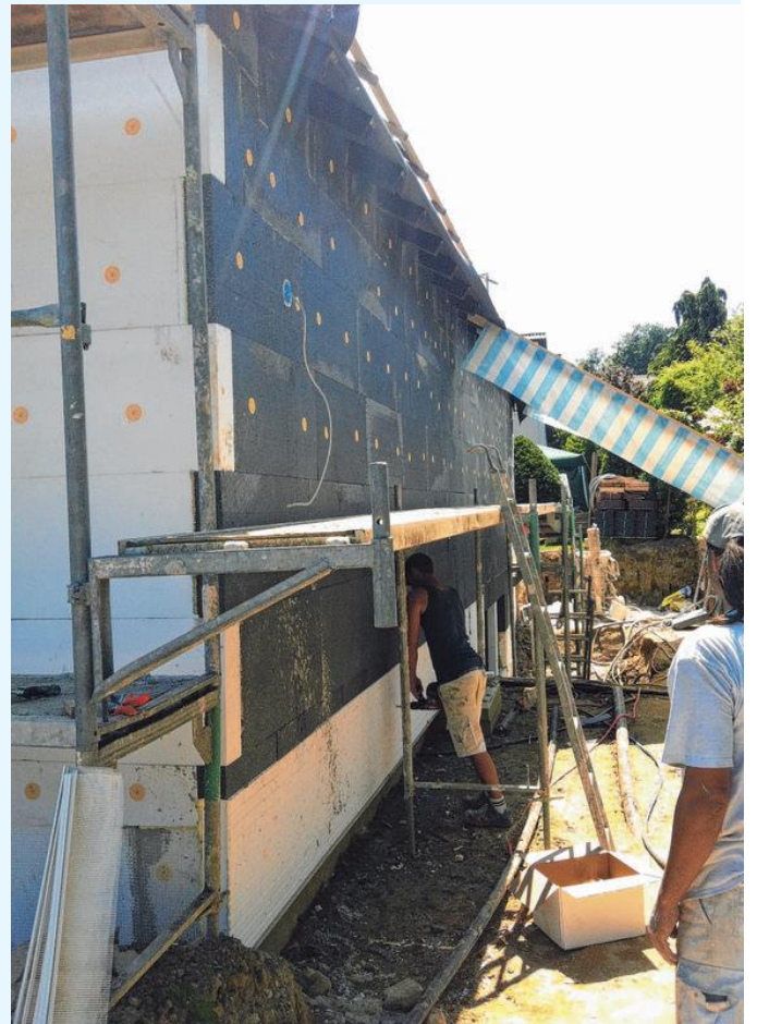
Hier wird ein Haus energetisch saniert. FOTO: PR
